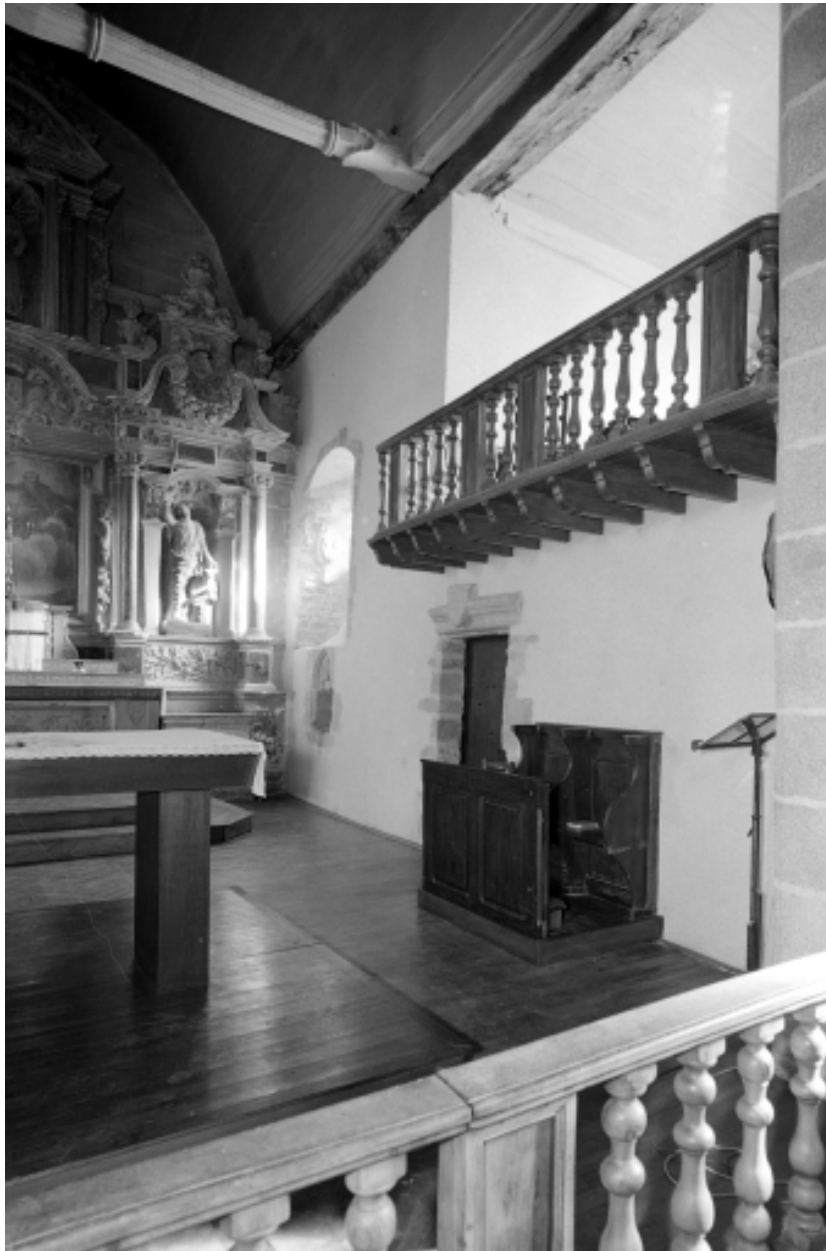
Intérieur, chœur, mur sud : vue générale.
