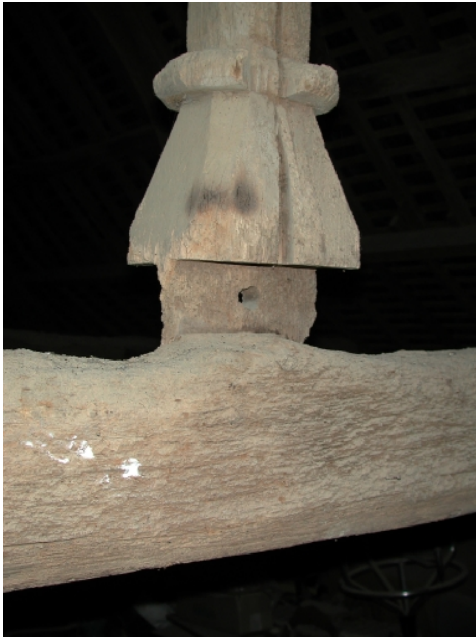
Charpente ; poinçon, partie basse
