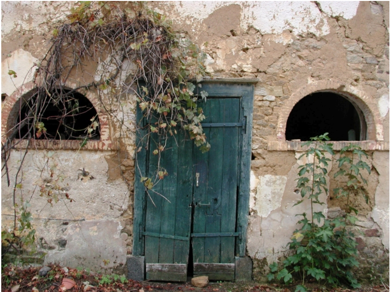
Détail de l'élévation sud des anciennes écuries
