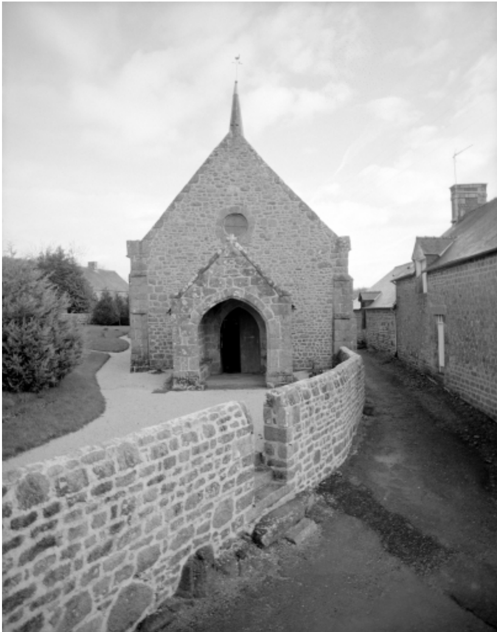
Elévation Ouest : vue générale
