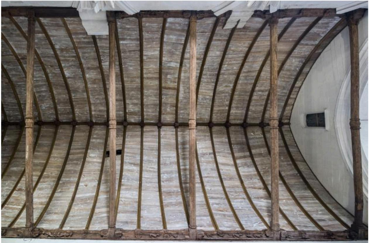
Vue de la charpente lambrissée en berceau brisé couvrant le vaisseau central de la nef.
