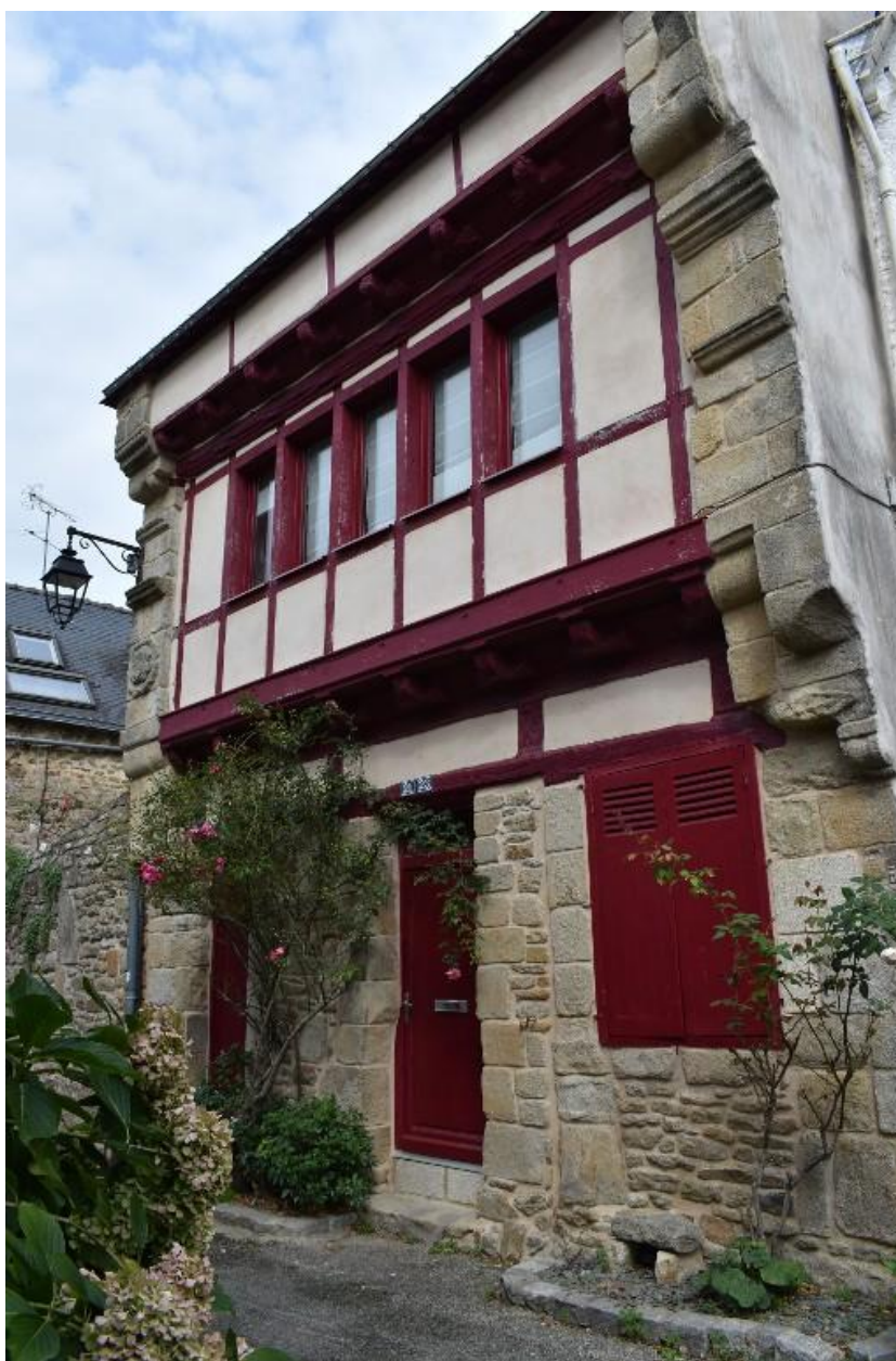
Façade à pan de bois avec encorbellement sur solives
