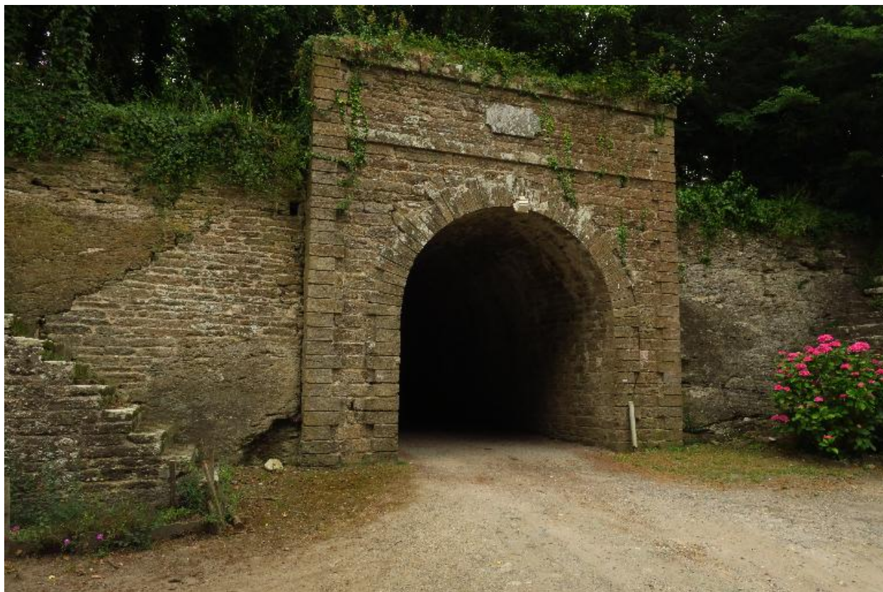
Groix, fort dit Fort Surville, tunnel du ravelin depuis l'intérieur.
