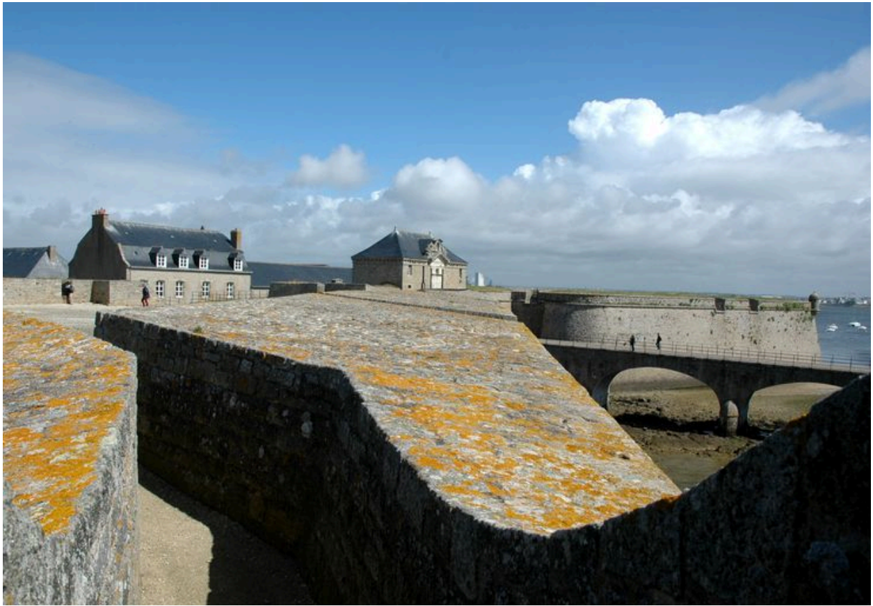
Vue générale de la citadelle de Port-Louis depuis l'échauguette du bastion de Groix
