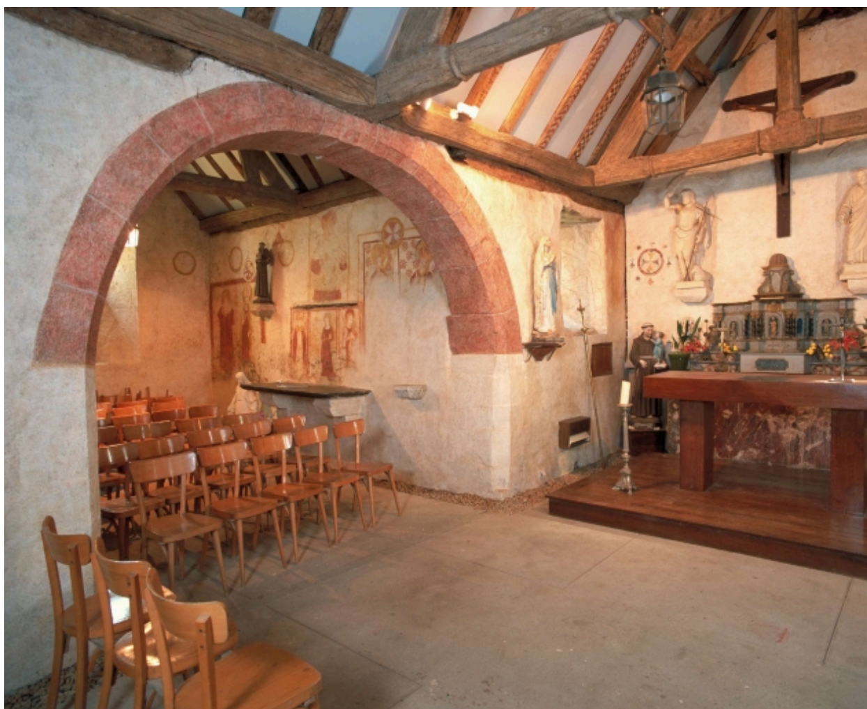
Vue intérieure, bras nord du transept
