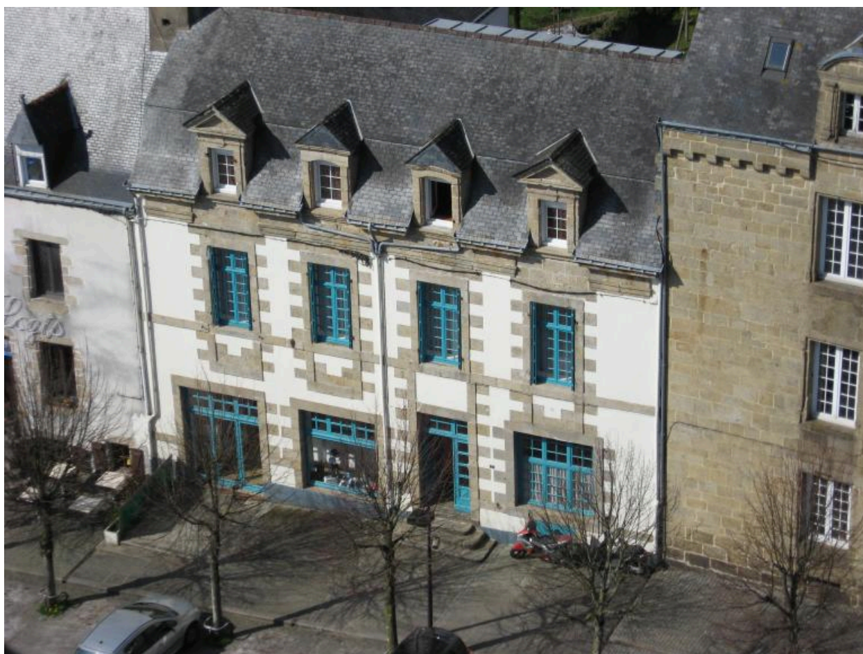
Maison Ponsard, vue générale
