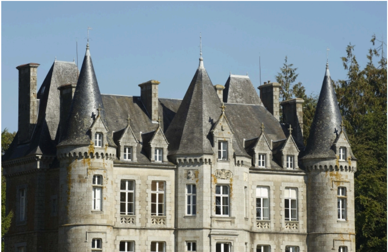
Vue sud-ouest, détail des toitures
