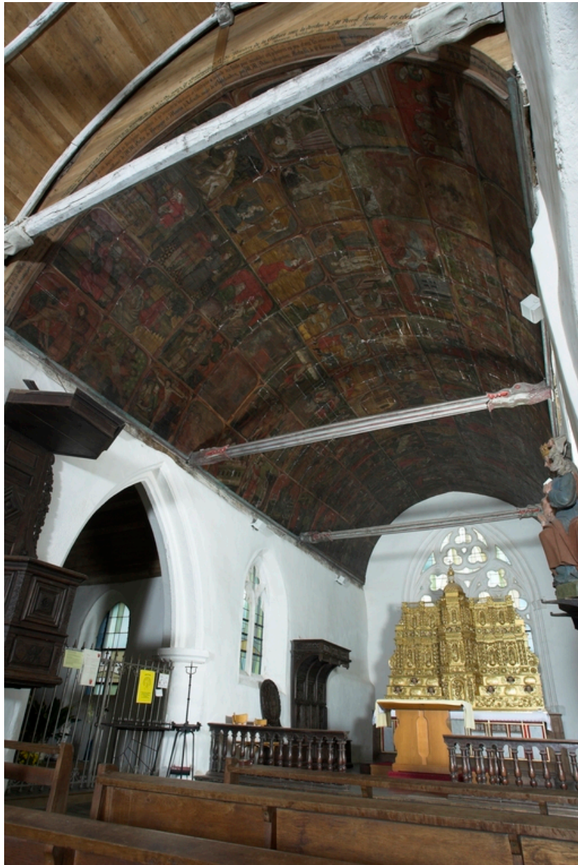
Vue en contre plongée de la fausse voute peinte
