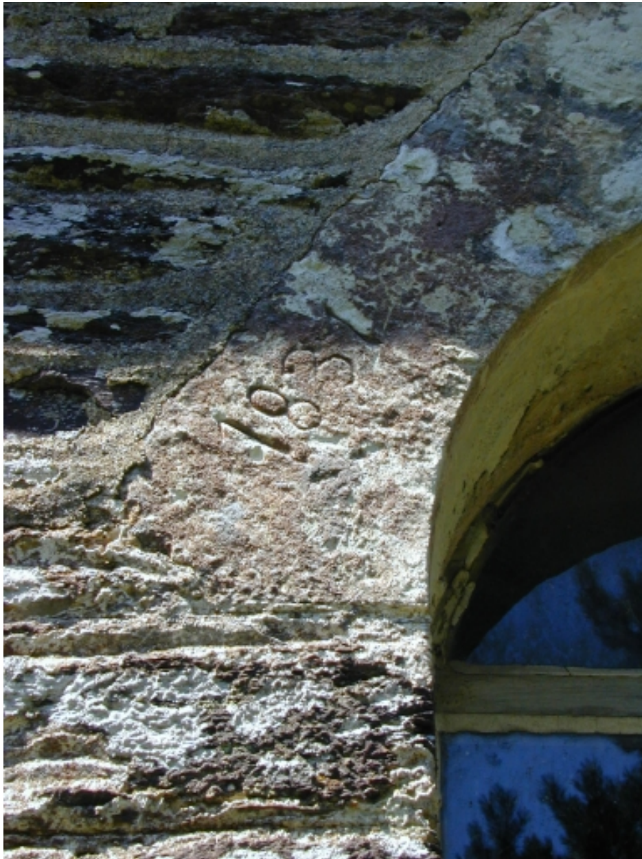
C ti re sud, premi re baie   partir de l'ouest : d tail de la date grav e
