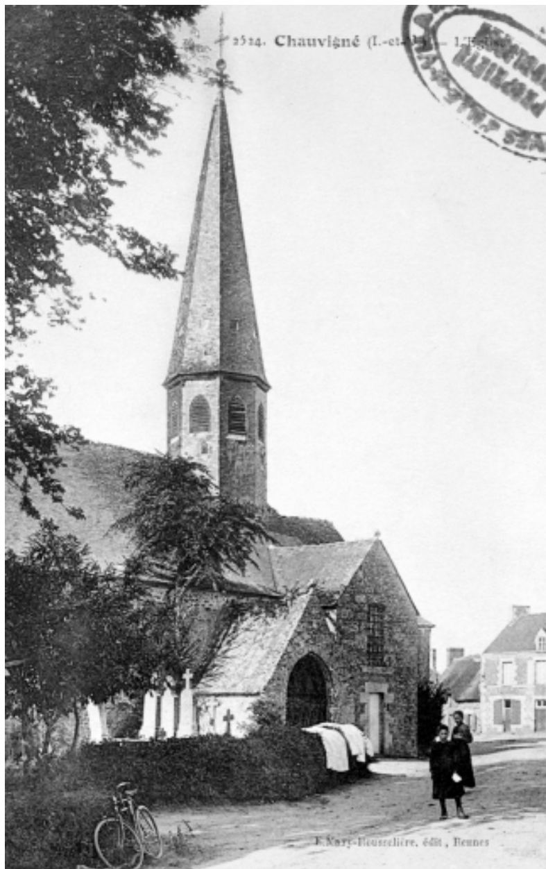
Elévation sud : vue générale (carte postale, limite 19e - 20e siècles)
