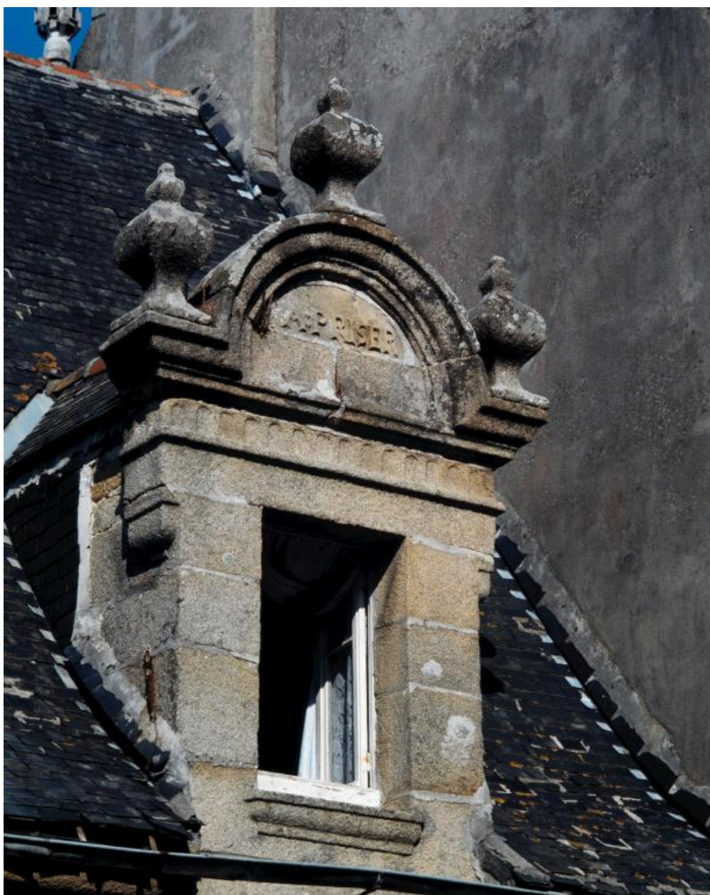
Elévation ouest, détail de la lucarne droite et inscription A : PRISER. (1989)
