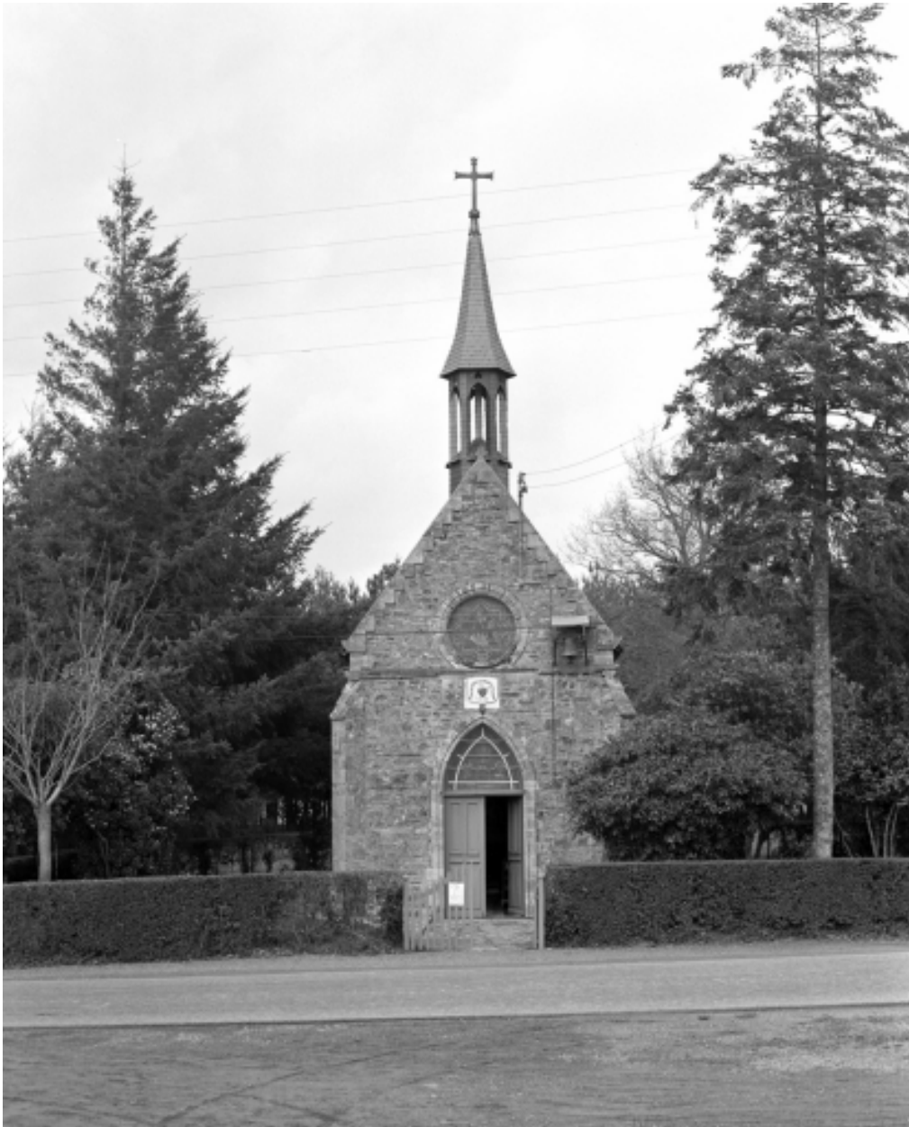
Façade : vue générale sud
