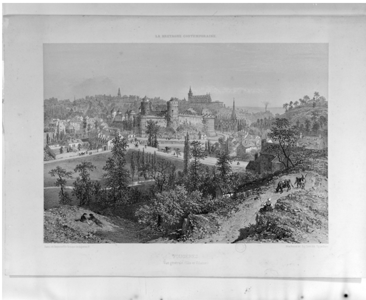
Vue de situation nord-ouest.
