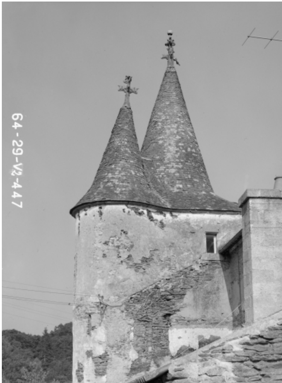
Pavillon d'escalier, couverture
