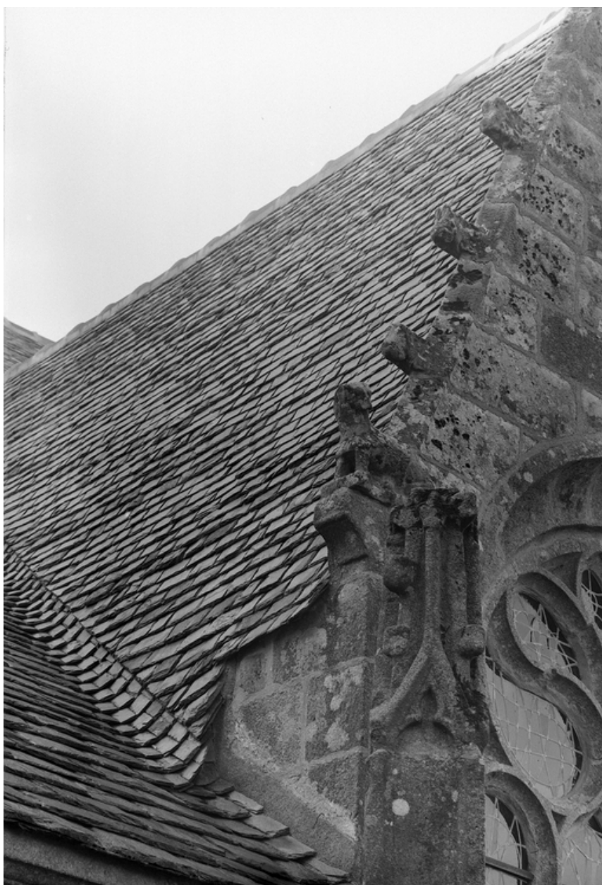
Bas-côté nord, fenêtre ouest : crossette sculptée, côté est
