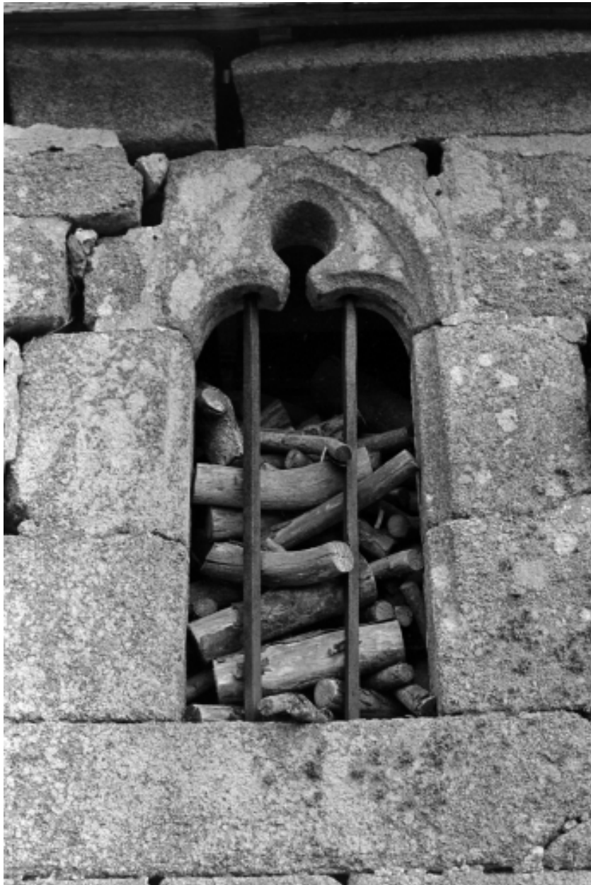
Chapelle : détail d'une baie
