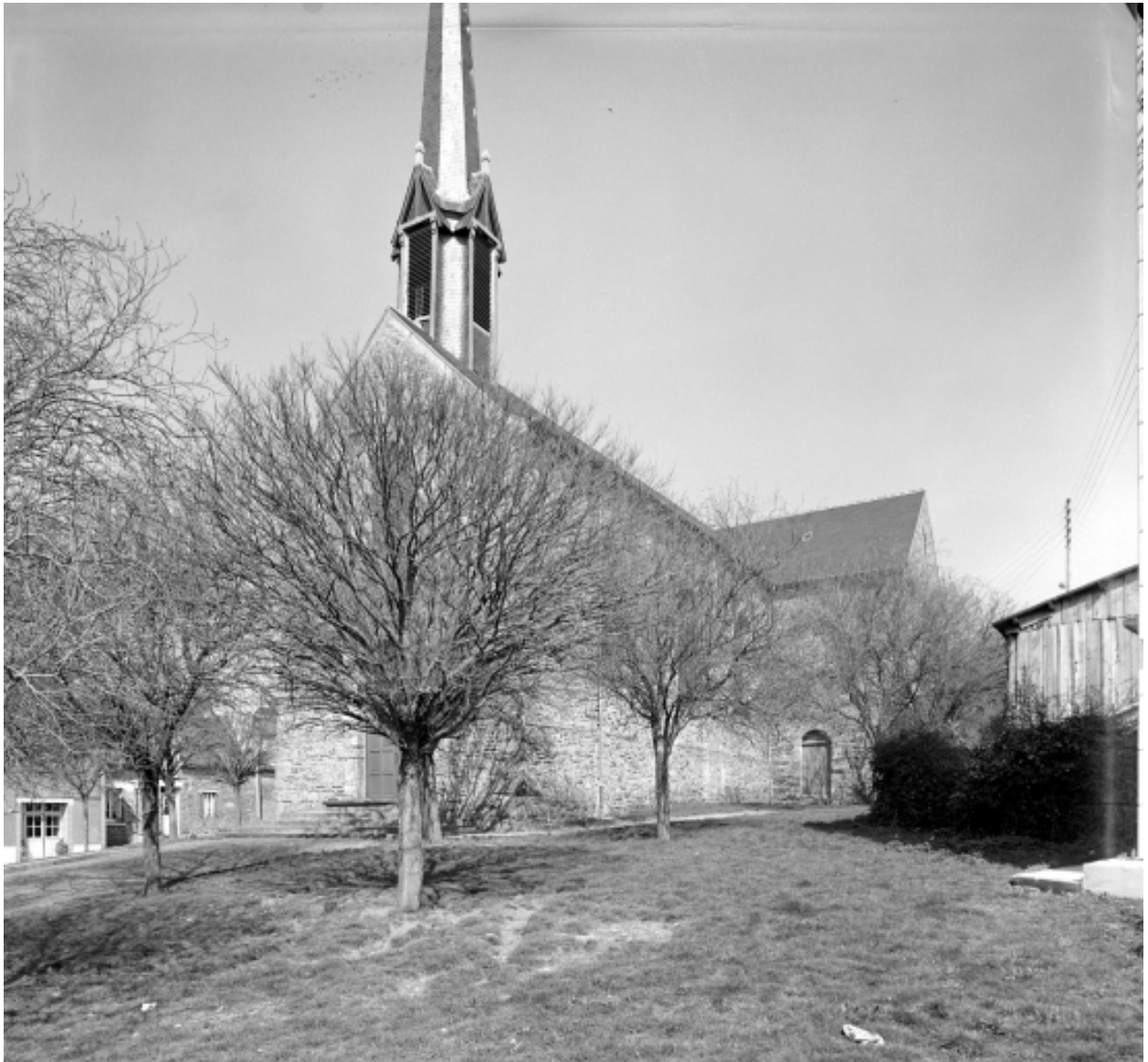
Elévation Sud-Ouest : vue générale
