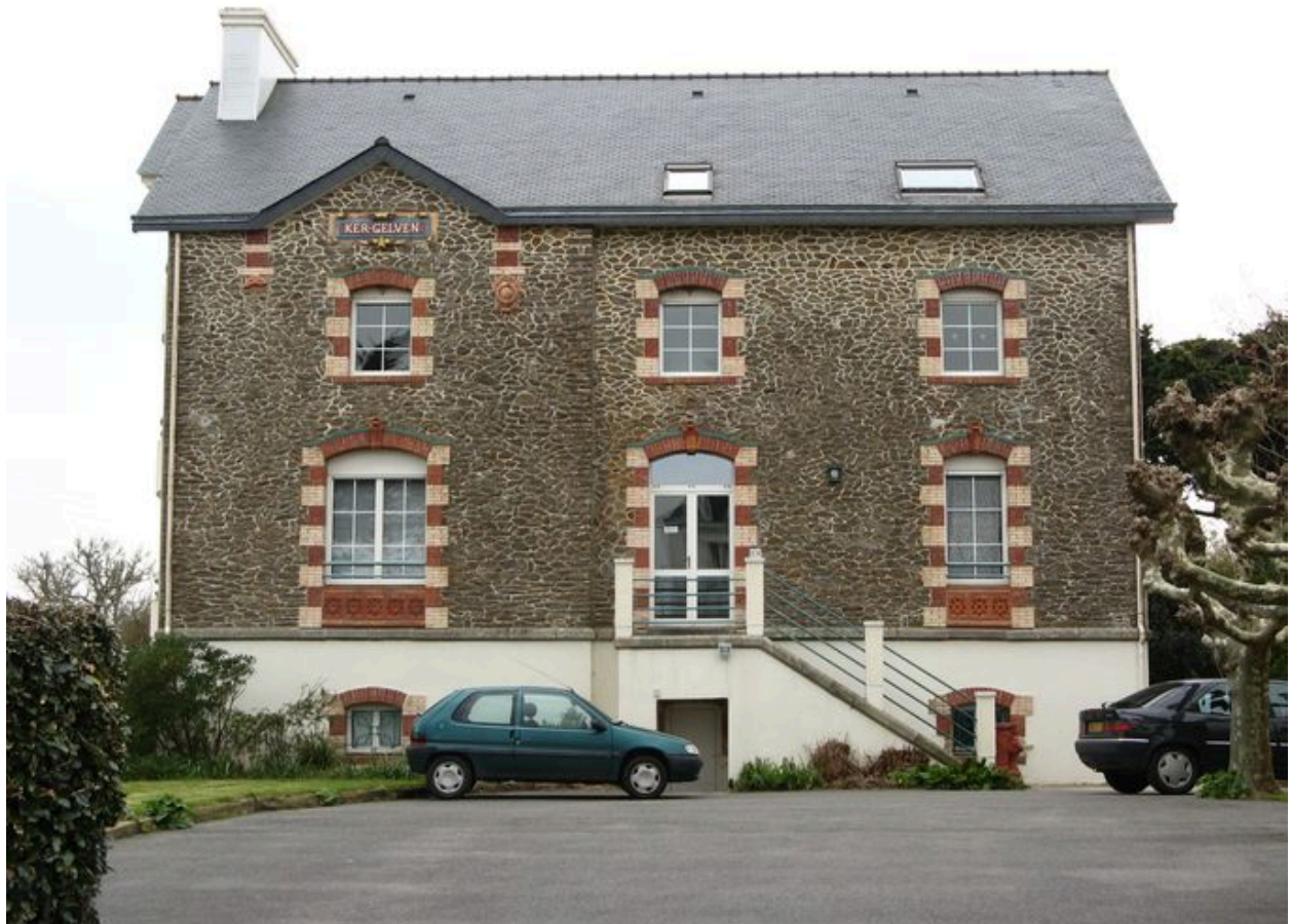
Façade principale de la résidence Ker Gelven
