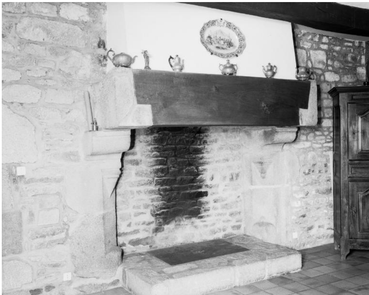
Rez-de-chaussée, cheminée sud.
