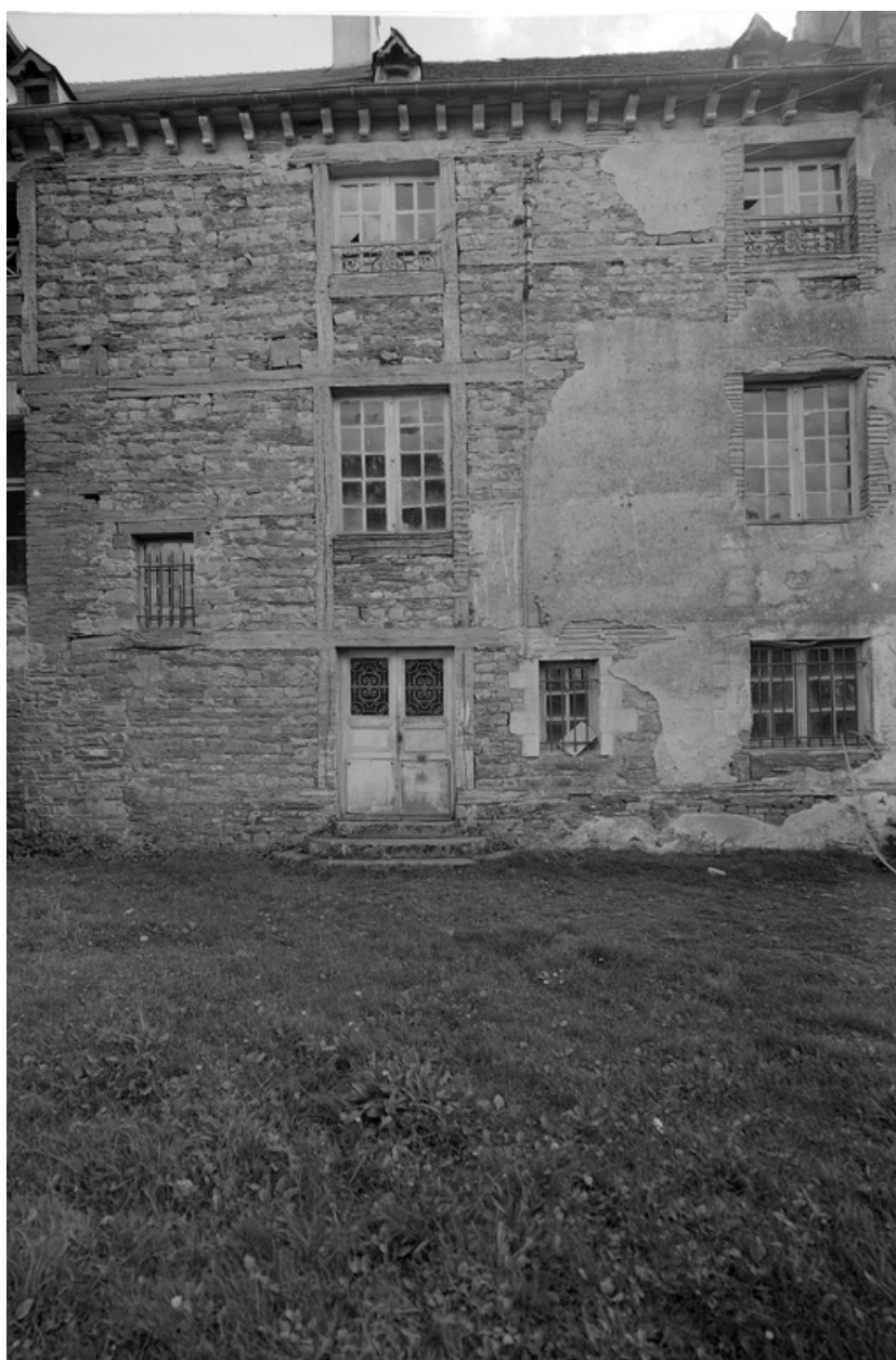
Façade nord, partie ouest.
