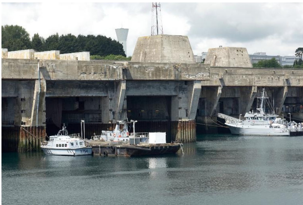
Vue de la base de sous-marins depuis l'intérieur de l'enceinte de l'arsenal : détail du front sud-est
