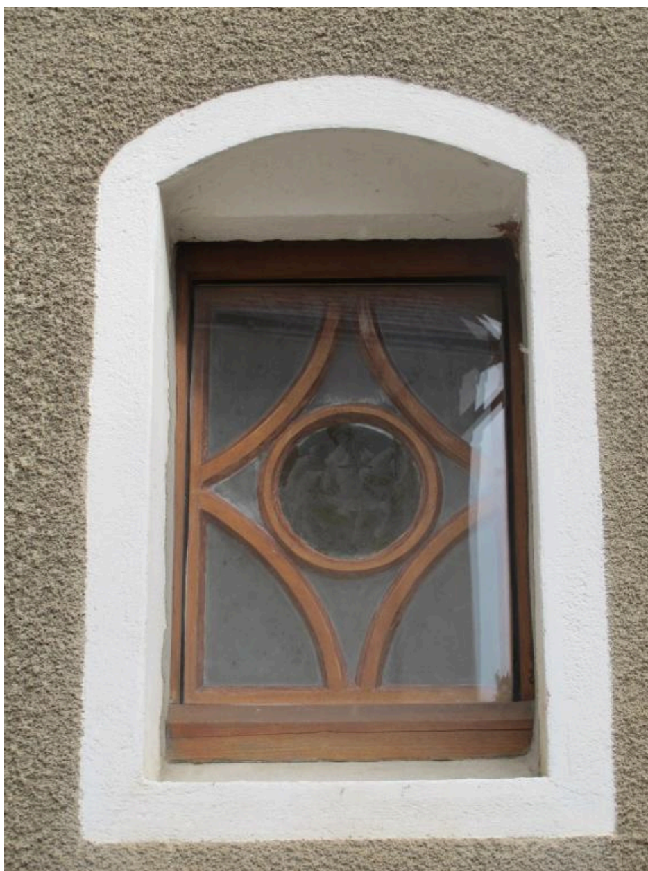
Façade nord. Rez-de-chaussée, partie ouest, fenêtre ouest
