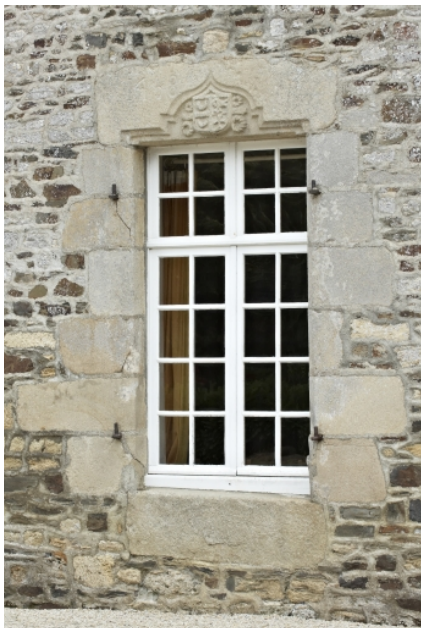
Fenêtre du rez-de-chaussée avec linteau remployé
