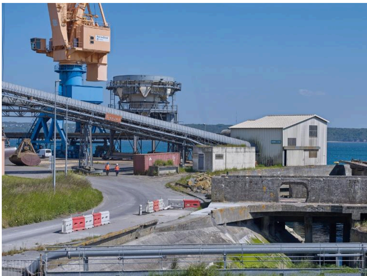
Quai caboteurs : grue, bandes transporteuses, trémie et conteneurs
