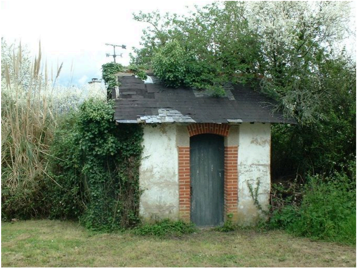
Dépendance de l'ancienne caserne des douaniers des Quatre-Vents
