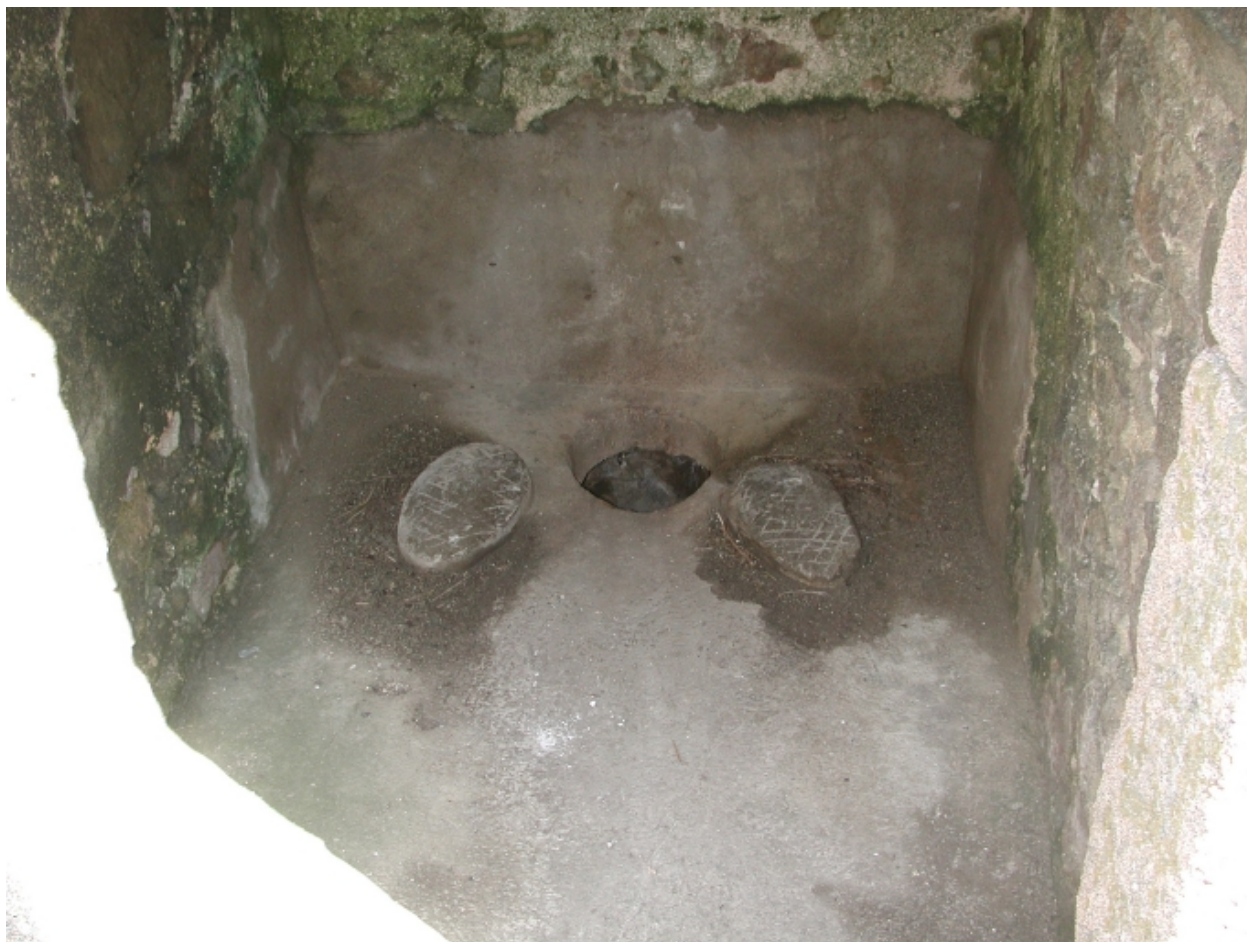
Détail de l'intérieur des latrines (encore utilisées aujourd'hui)
