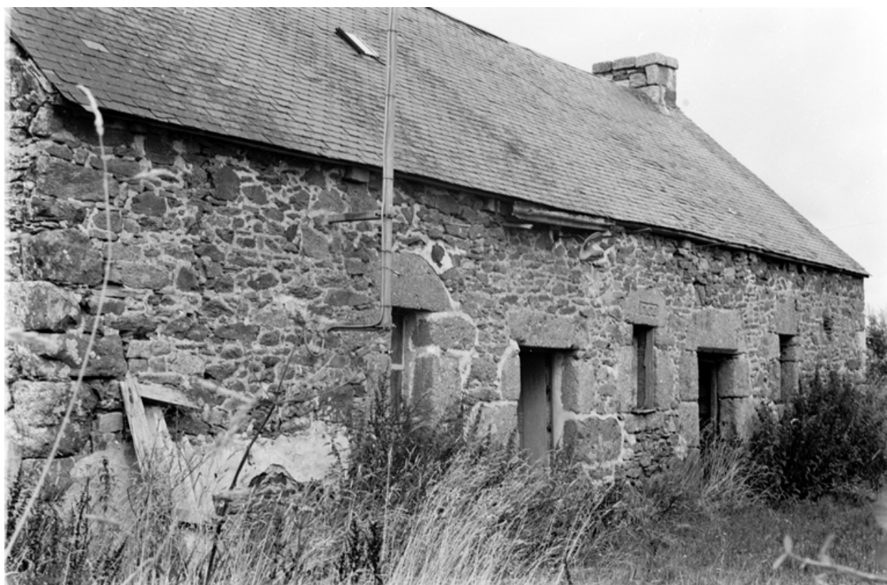
Maison (les 4 vents) : vue générale de la façade
