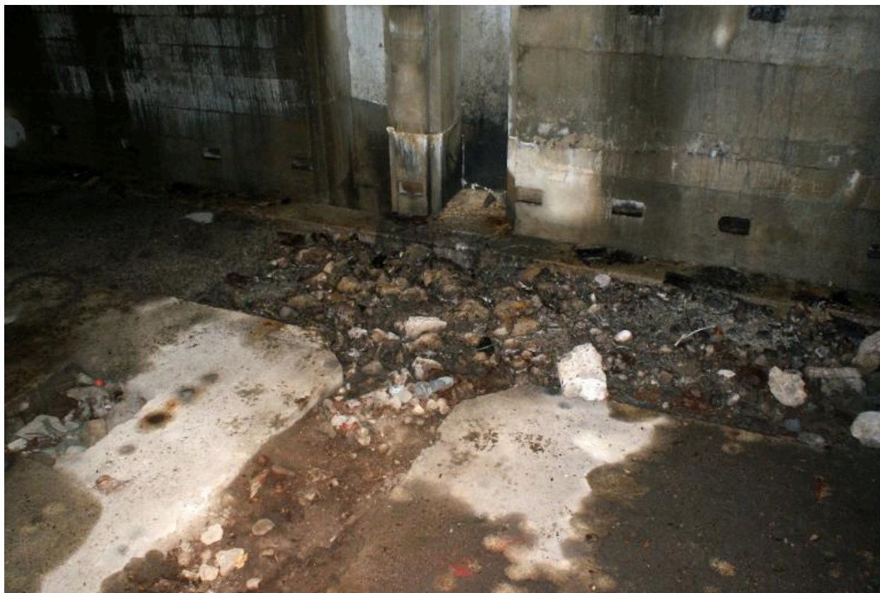
Vue intérieure : gaine technique aménagée dans le mur gouttereau et le sol (état en 2013)
