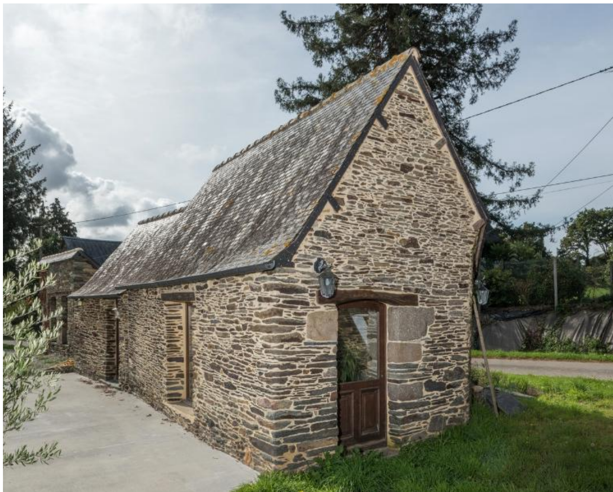
Alignement formé par deux étables et une soue. Vue générale nord
