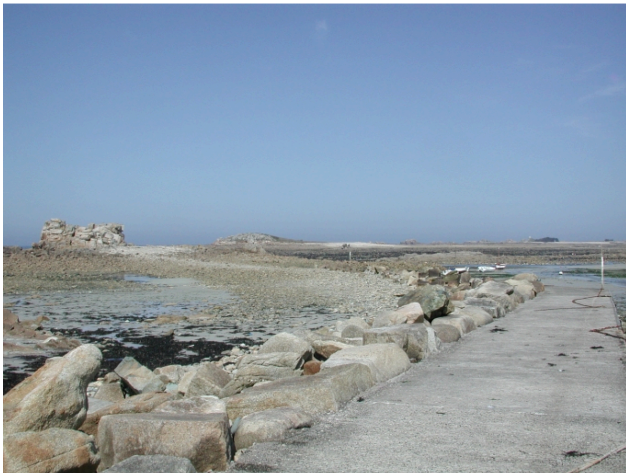
Vue du recouvrement en ciment de la cale et des enrochements contre le mur ouest du quai
