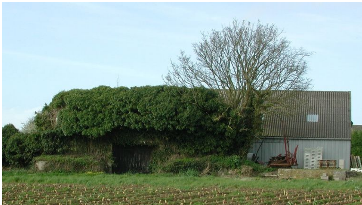
Vue générale de la casemate ouest (état en 2002)
