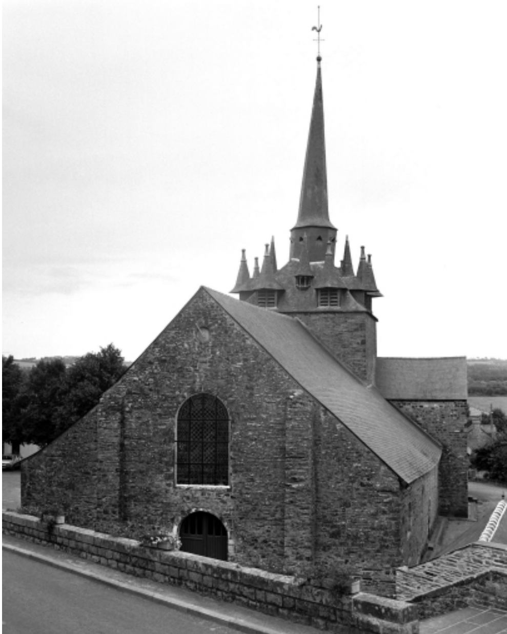
Elévation ouest : vue générale
