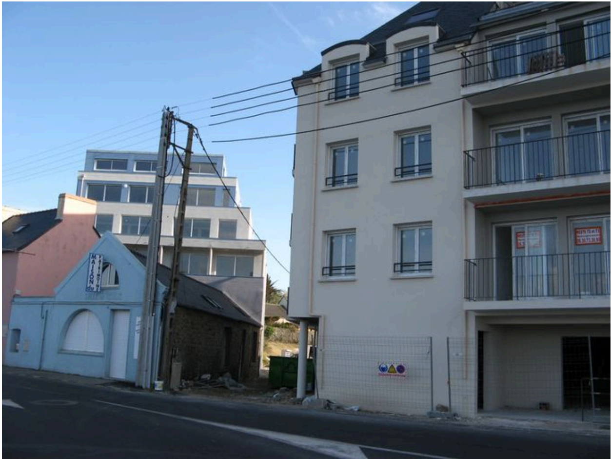
Nouveaux bâtiments construits en 2007-08
