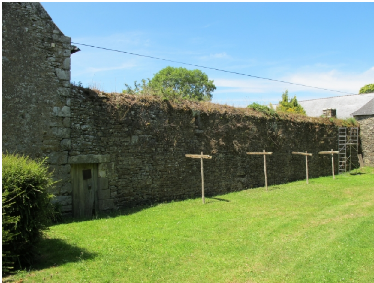
Mur d'enclos est, vue générale
