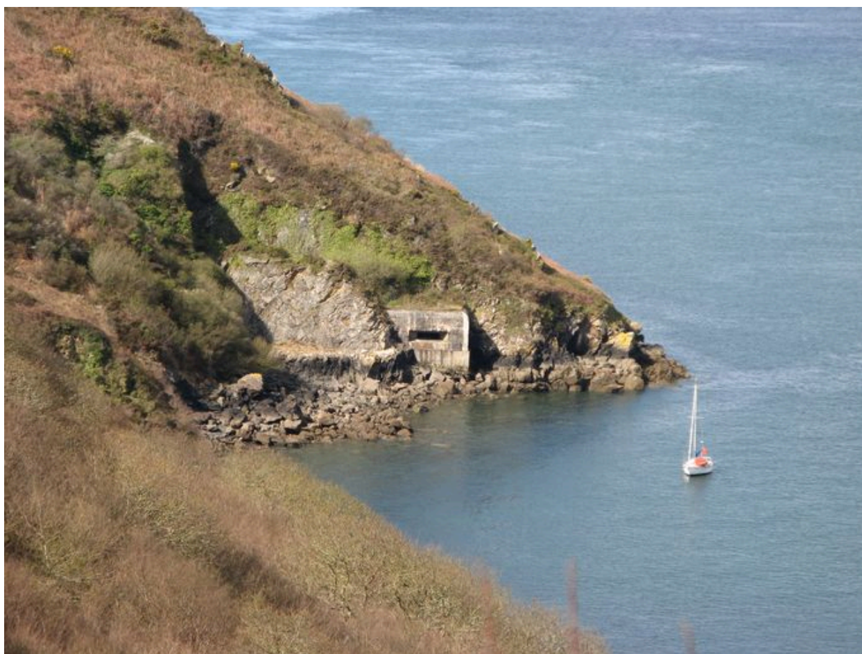
Situation de la batterie de rupture de Pourjoint
