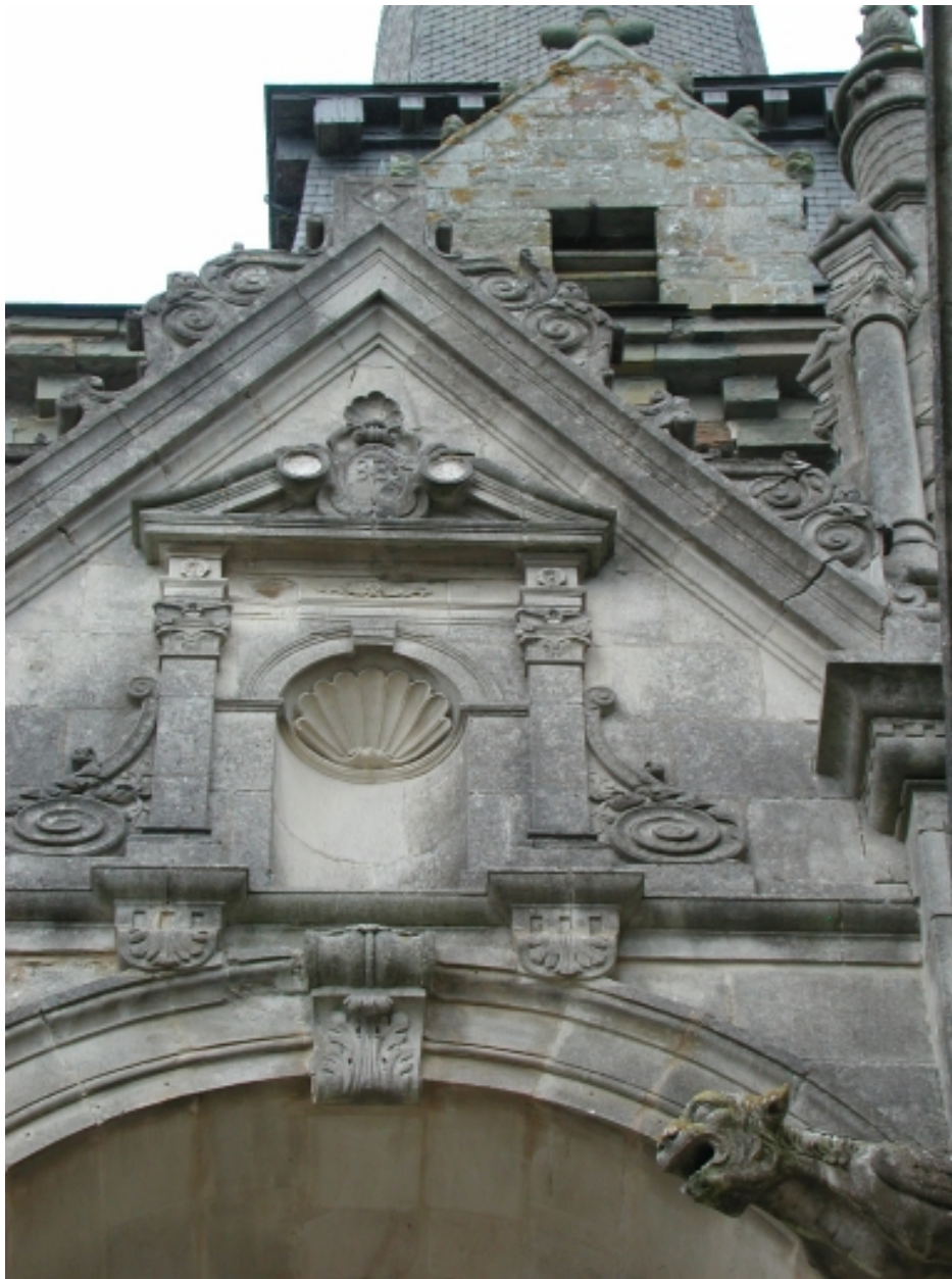
Détail ; porche sud
