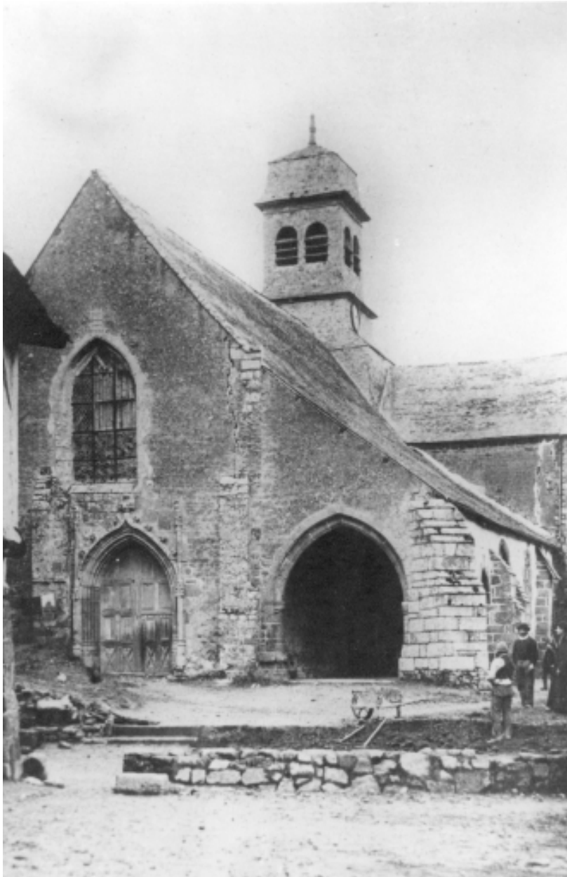
Vue générale ouest de l'ancienne église paroissiale
