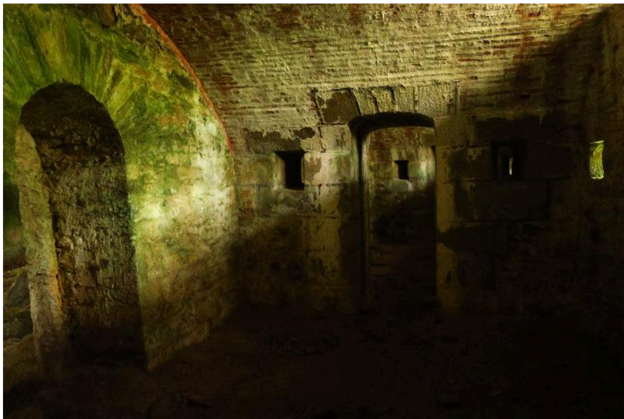
Le Palais, enceinte urbaine, galerie de contrescarpe, casemate.
