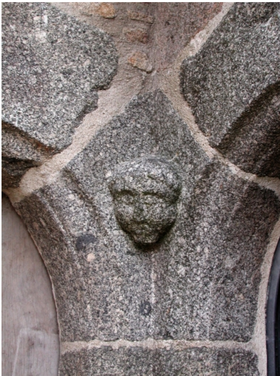
Vue de détail de la tête de moine sculptée sur le pilier en granite commun aux deux ouvertures
