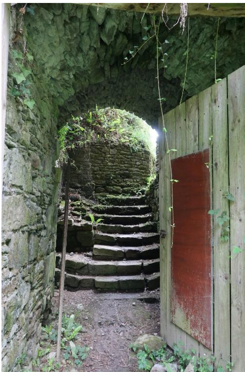
Vue de la porterie ouest : passage d'entrée et escalier
