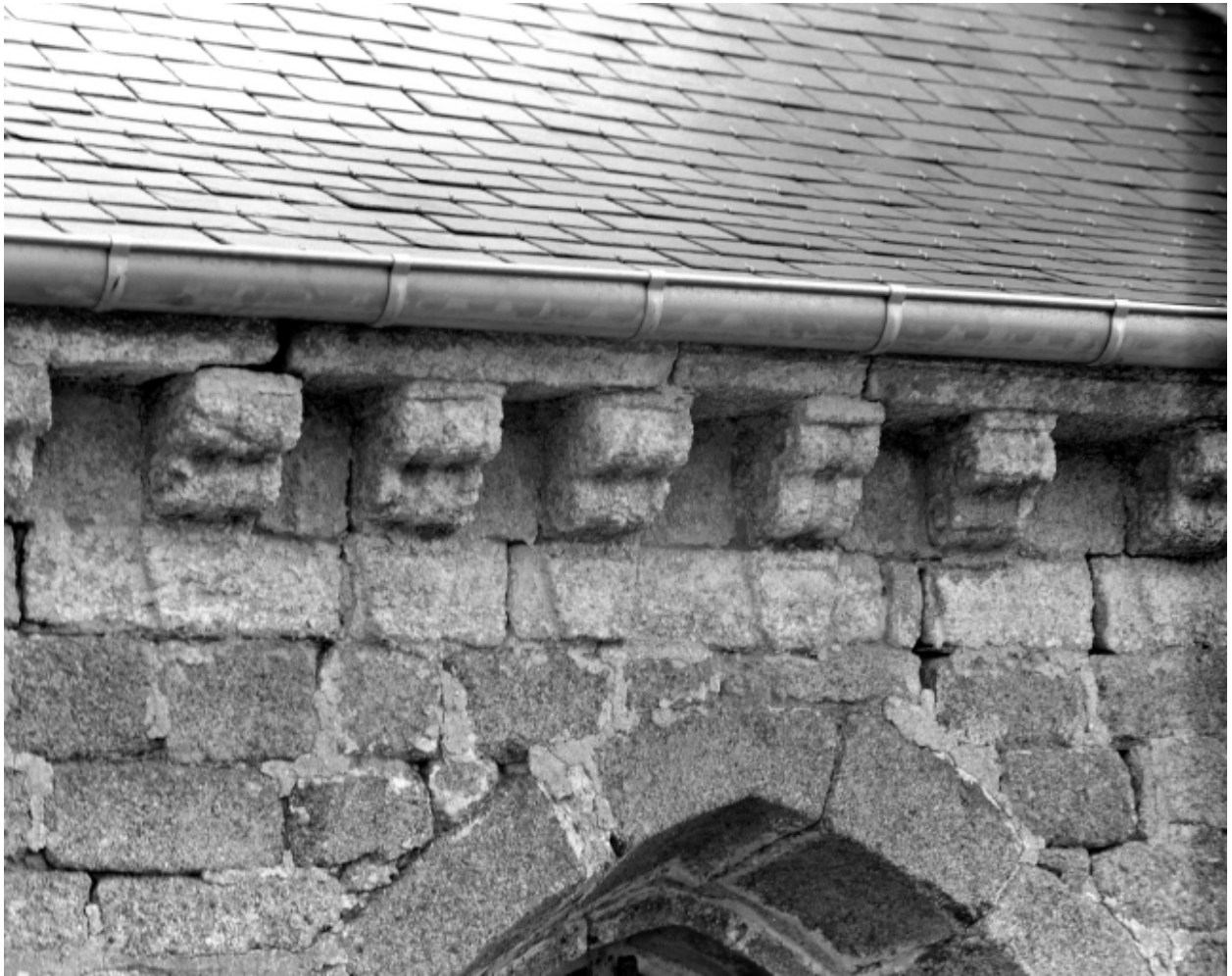
Elévation ouest, corniche : détail des modillons
