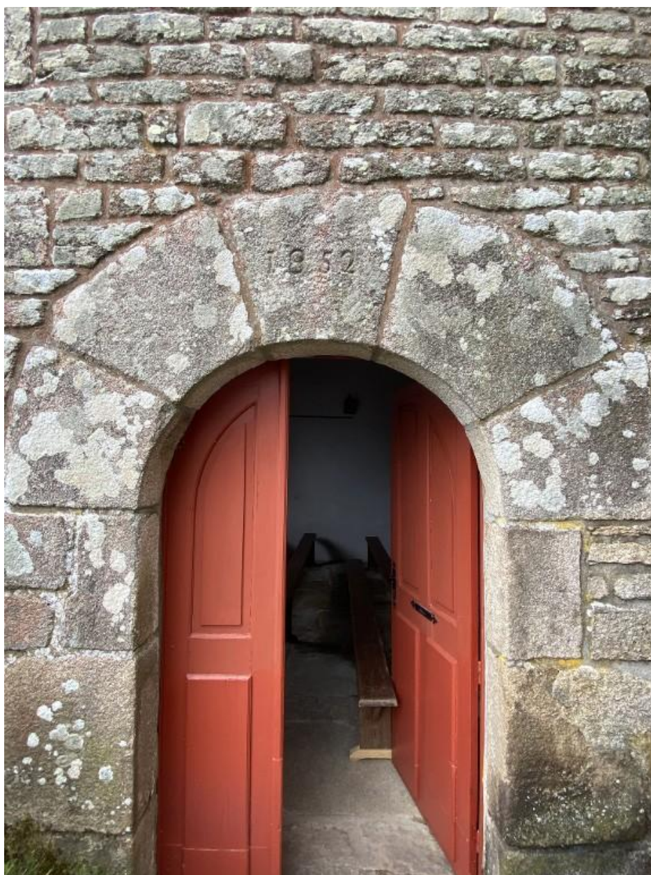
Porte en plein cintre datée, détail, vue ouest
