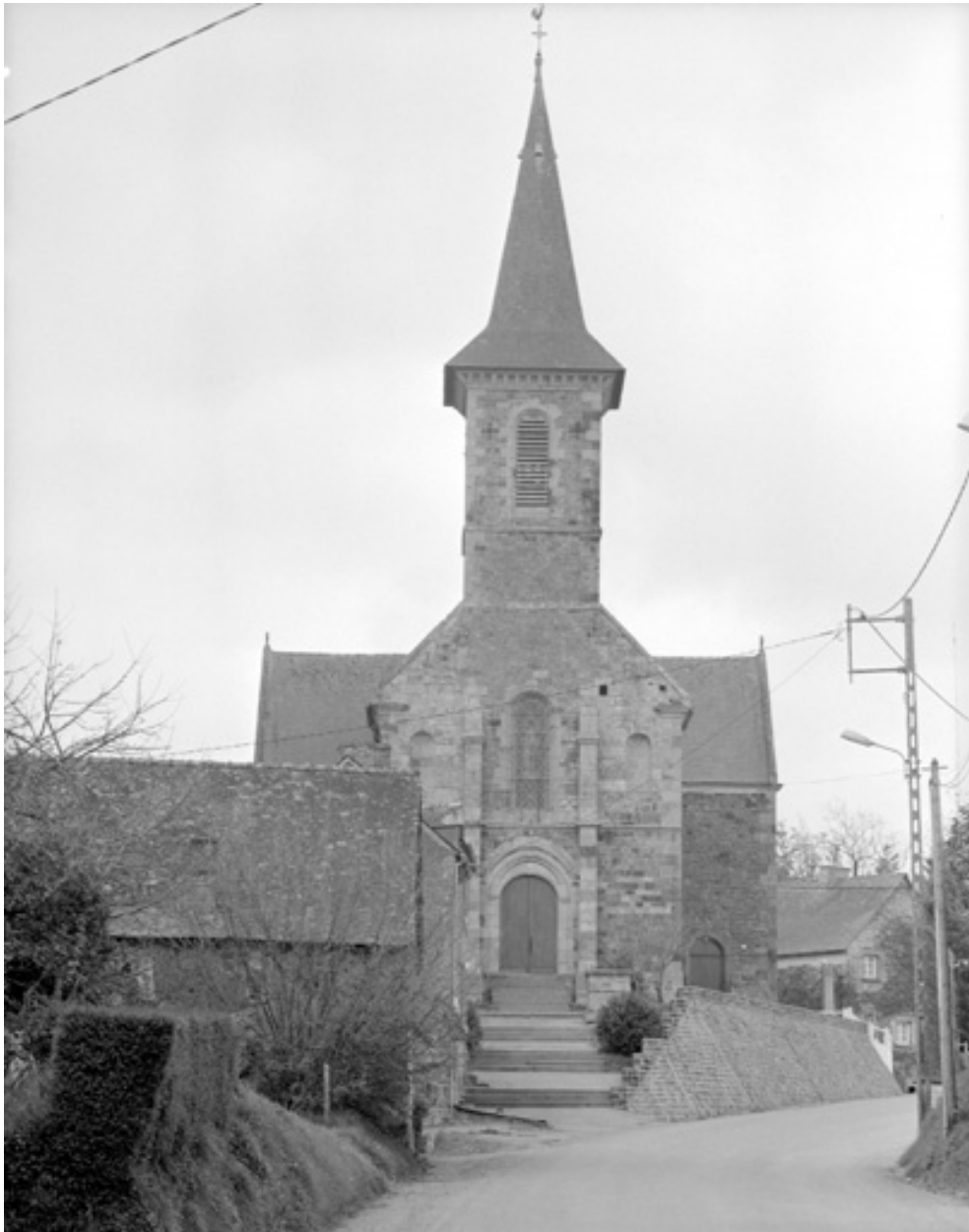
Elévation Ouest : vue générale
