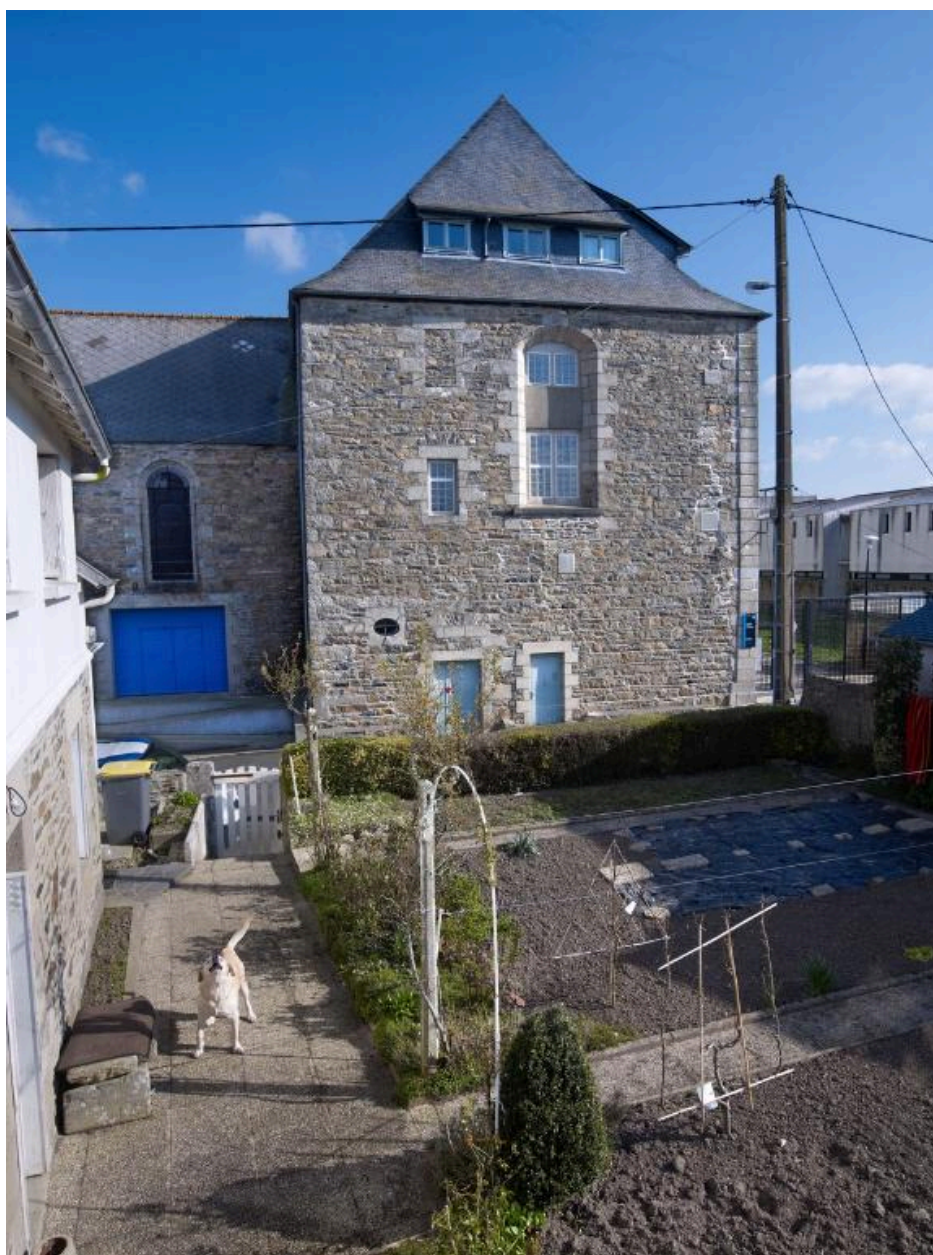
Grand corps de logis. Pignon ouest avec fenêtres superposées éclairant l'escalier et grande baie cintrée éclairant le couloir des cellules des 1er et 2e étages. Vue générale
