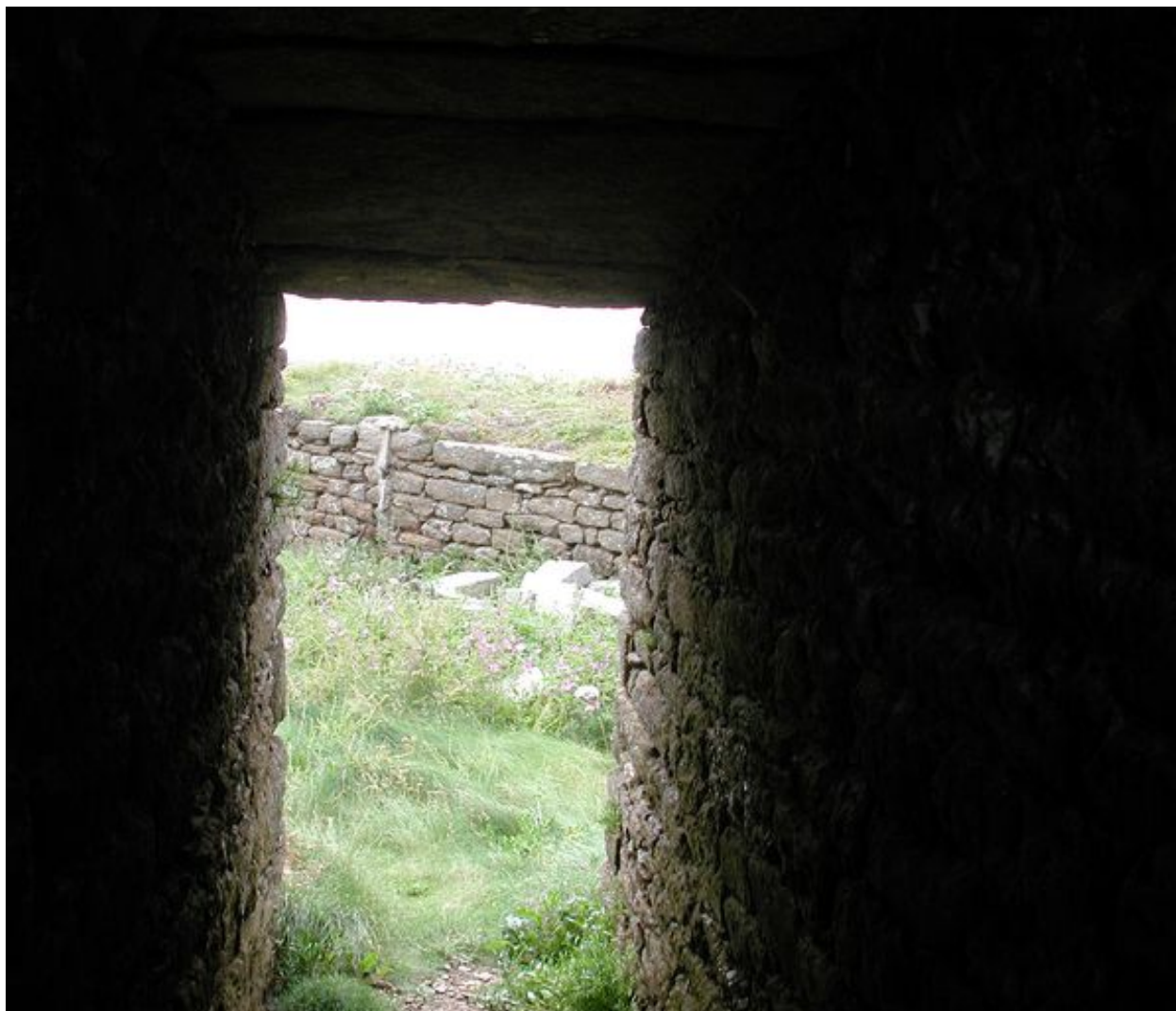
Vue de la galerie de communication avec la batterie basse (état en 2006)
