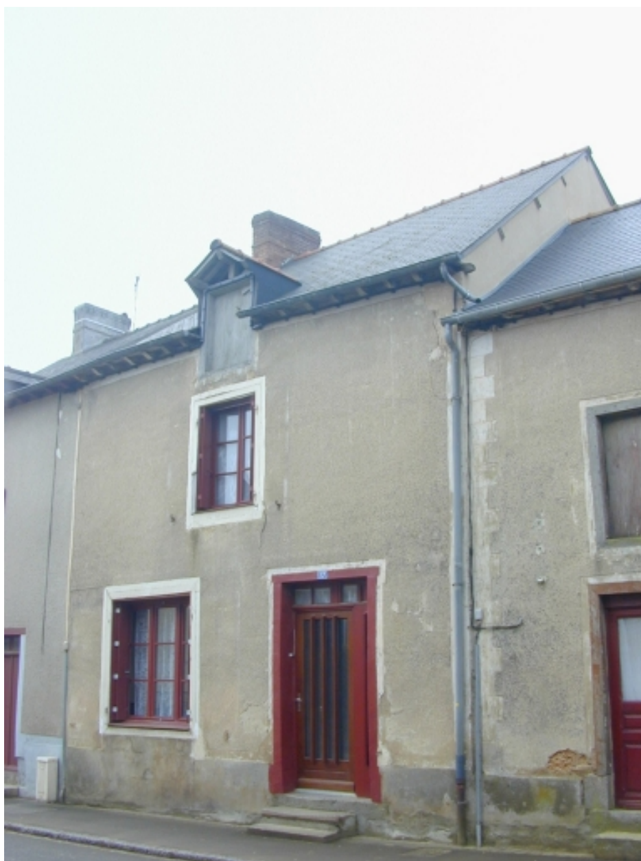
Vue générale nord-est
